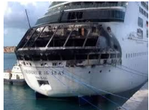
Phần bị cháy
